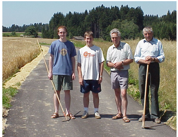
Die fleißigen Arbeiter beim Befestigen des Banketts: Georg Höllrigl, Harald Gretz, Franz Höllrigl, Othmar Boden
